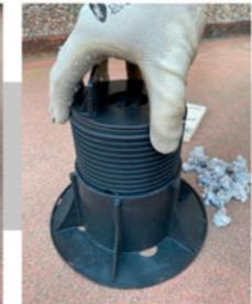
Preparazione dei supporti regolabili. Inserimento isolante sfuso termoacustico e chiusura
