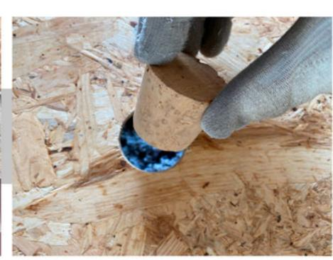
Foratura lastra calpestabile, insufflaggio isolante e chiusura dei fori
